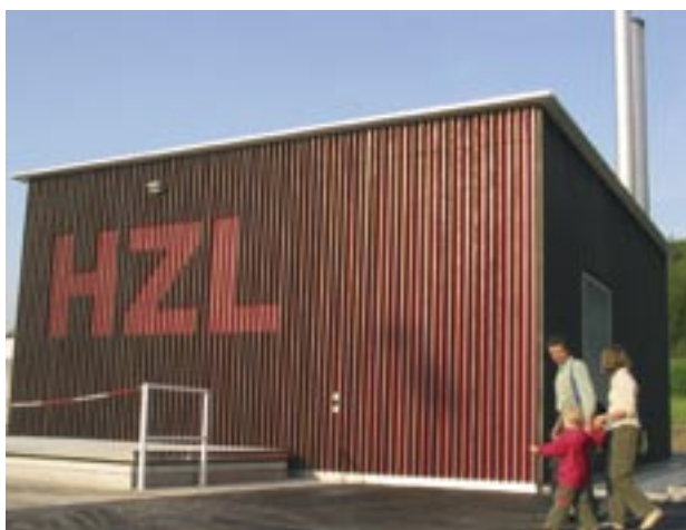
Mit der Realisierung der neuen Heizzentrale Lättich hat die Korporation Baar-Dorf bewiesen, dass ihr eine nachhaltige und zukunftsfähige Energieversorgung ein echtes Anliegen ist.
