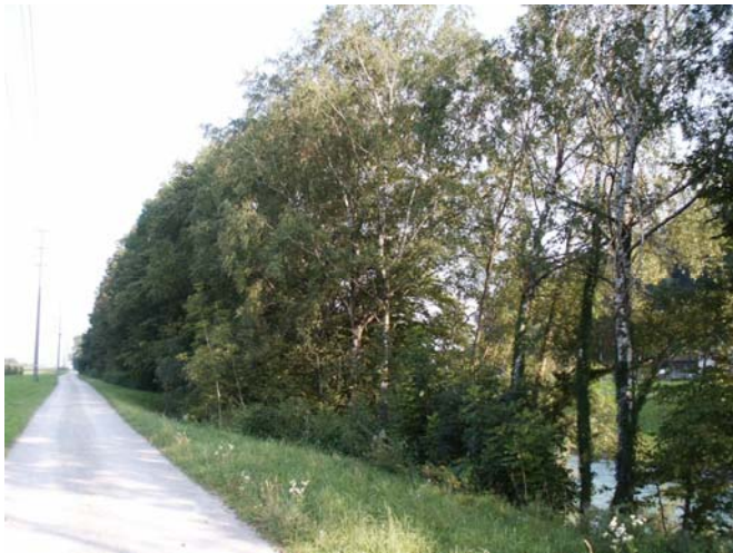
Abbildung 1: Uferböschung der Linth
