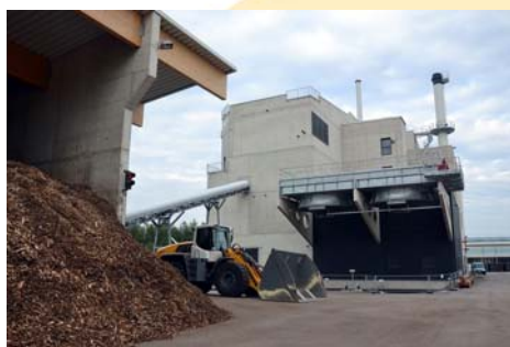
Holzkraftwerk (Dampf) Axpo Tegra, Domat/Ems 16'000 kW el , 82'000 kW th
