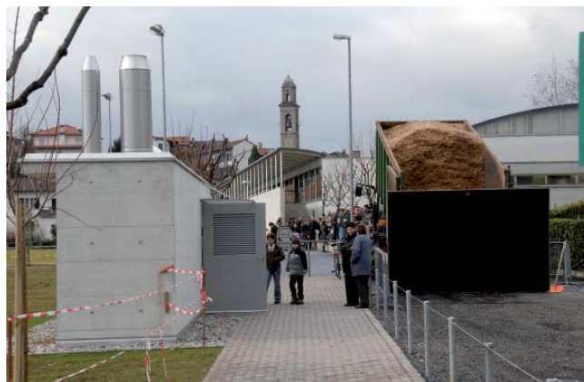
Holz-schnitzelnachschub für den Wärmeverbund Coldrerio (TI)
