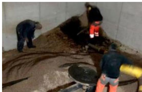
Bild 5: Links: Lagerraum mit Wassereinbruch von oben.
