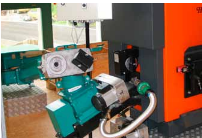
Holzsnitzelkessel (30 kW Leistung) mit Schnitzelzufuhr und Rückbransicherung.
