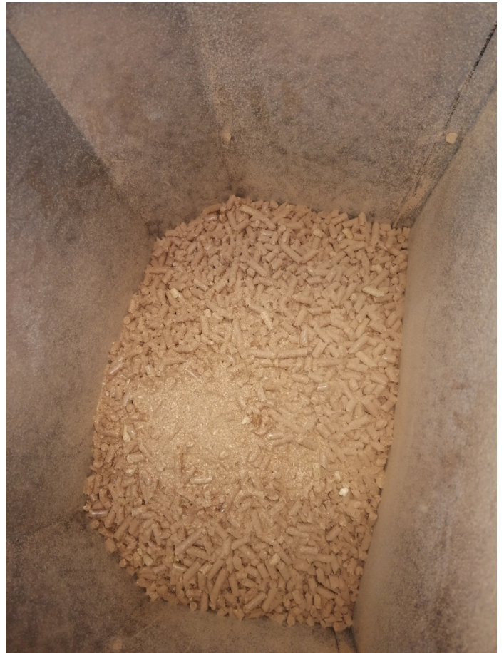
Blick in den Speicher, aus dem der Ofen mit Pellets versorgt wird. Foto: FHNW
