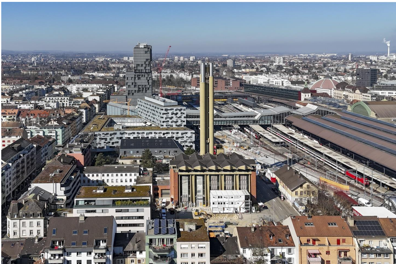
Quelle: IWB Heizzentrale Gundeli, Basel, ©IWB/julian_salinas
