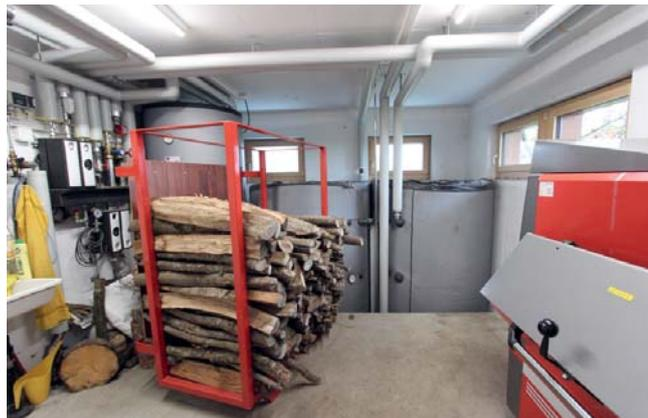
**Accumulo:** per poter scaldare l'edificio in base alle necessità, una caldaia a legna in pezzi richiede in ogni caso un sistema di accumulo dell'energia. L'installazione del serbatoio di accumulo all'interno dell'area riscaldata (p. es. lavanderia) permette di evitare inutili perdite di calore.
